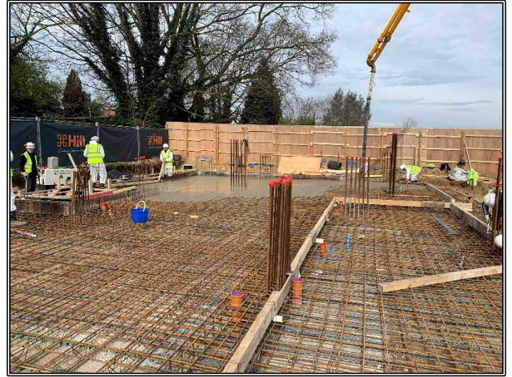
Concrete Pour in Progress
